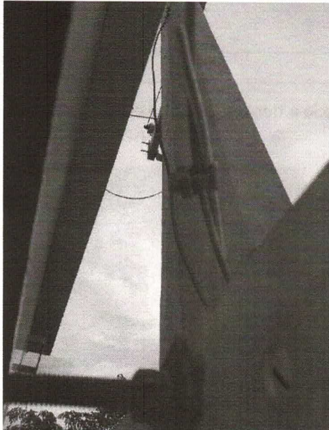
Colocación de los sistemas de tierras
